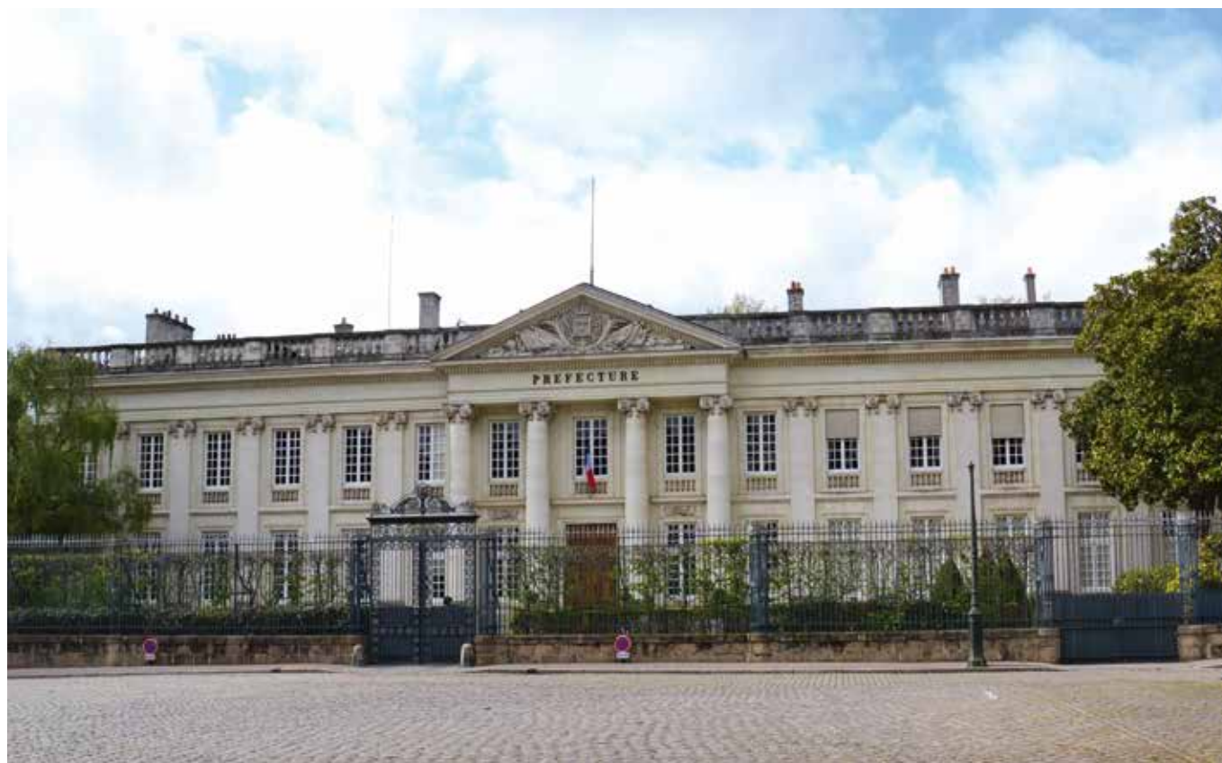
Fig. 6. Jean-Baptiste Ceineray, Chambre des comptes de Bretagne (actuelle préfecture des Pays de la Loire) bâtie à l'emplacement des enceintes, 1763-1769.
